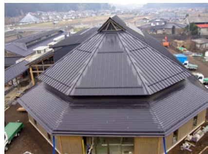
進捗率：100%（2月末現在）※外構工事を除く
