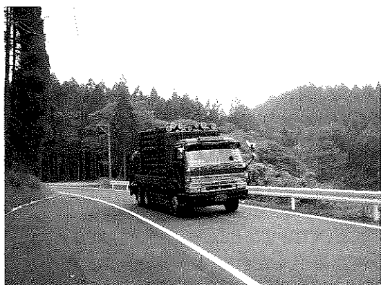
完成した農林業用道路 (矢田原)
