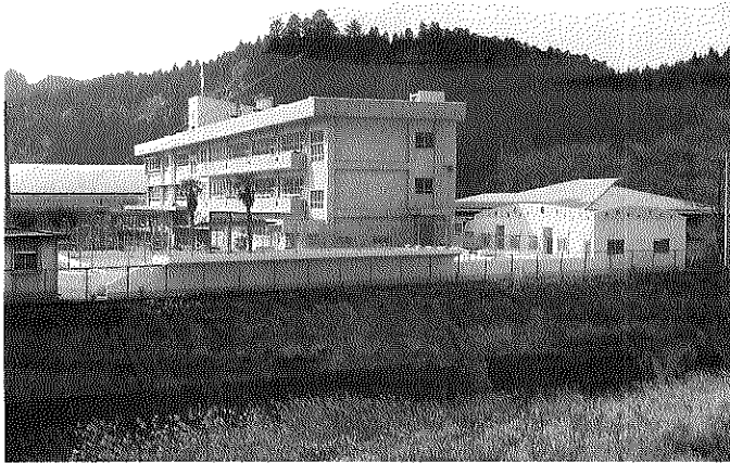
市原小学校プール改築工事
