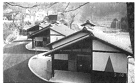
黒川小学校教職員住宅（黒小跡地）
