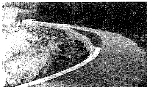
林道河内線 延長697m、幅員4.0m、工事費21,100千円
