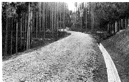
林構事業平瓜線(杉田~中原) 延長1.316m、幅員4.0m、工事費21,492千円
