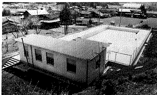
中原小学校プール
