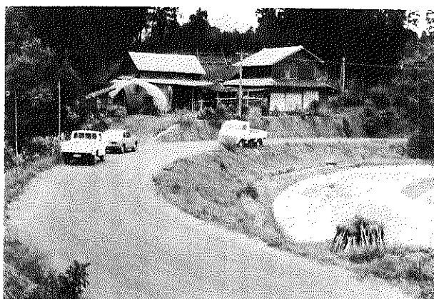
町道全面舗装着手 手形野
