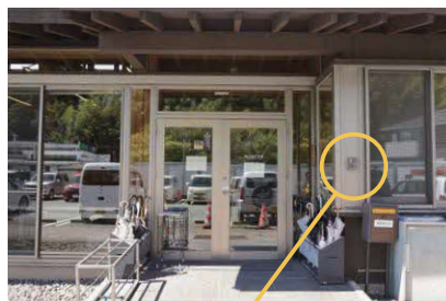
庁舎北側職員通用口横のインターホン
