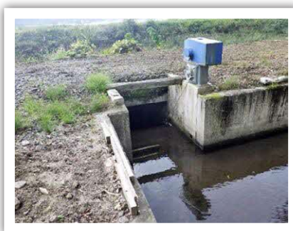
※1 自動転倒堰 せき 装置
