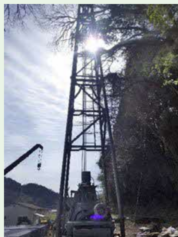
ボーリング作業のようす
