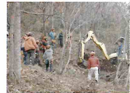
第4回 作業道開設研修
