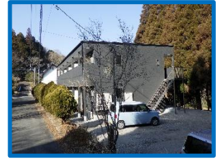
補助を受け建設された賃貸住宅
