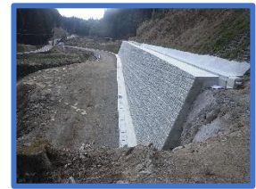
工事しゅん工（瓜上矢田原線）
