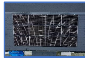
新たに太陽光発電設備を設置した住宅
