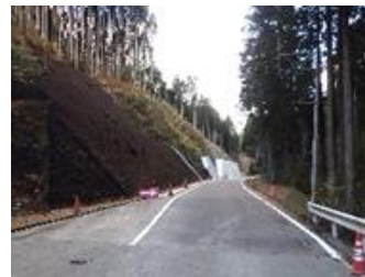
工事しゅん工（中湯田赤迫線）
