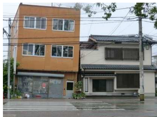
図 液状化による建築物の傾斜
