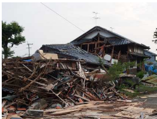
図 住宅の倒壊状況
