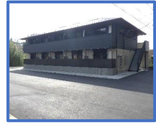
補助を受け建設された賃貸住宅
