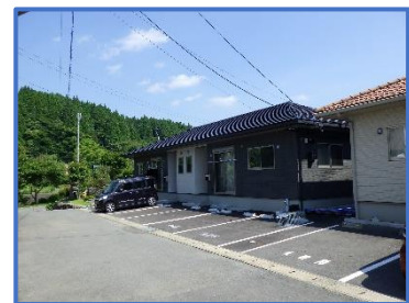
補助を受け建設された賃貸住宅
