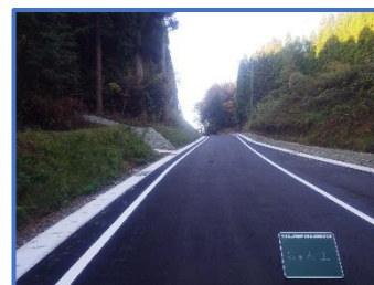
工事しゅん工（瓜上矢田原線）
