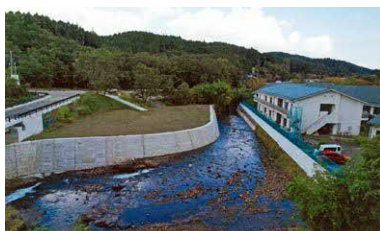
河川改修工事を終えた小田川 ／写真右が悠清苑
