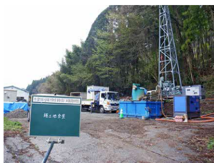
ボーリング工事風景
