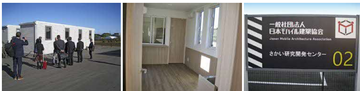
モバイル建築の建物（1ユニット）と内装
