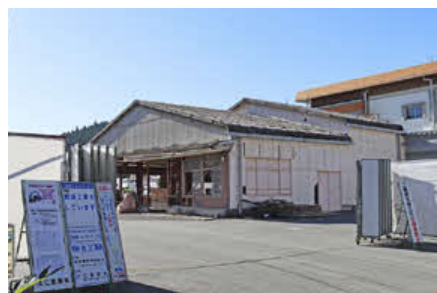
解体の進む農協施設
