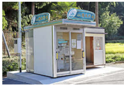
精米機のみ管理センター横に移設された
