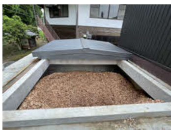
必要量のチップが保管庫から 燃焼機へ自動で送られます
